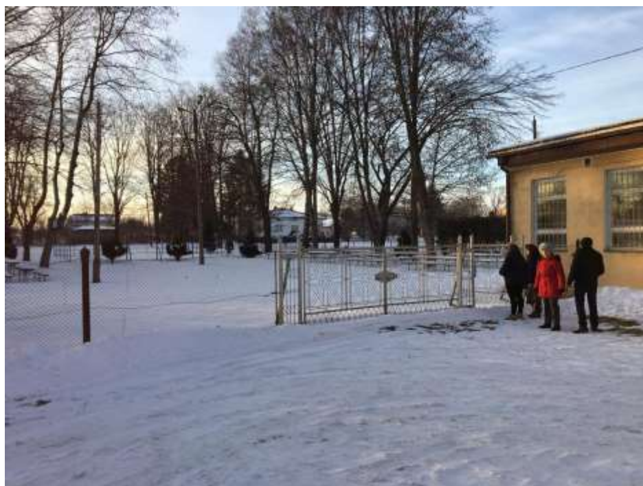
Tereny przyległe do budynku przy ulicy Decowskiego 46
