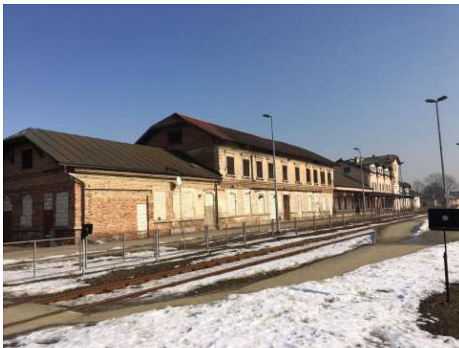
Budynek zabytkowego dworca PKP na Osiedlu Tysiąclecia
